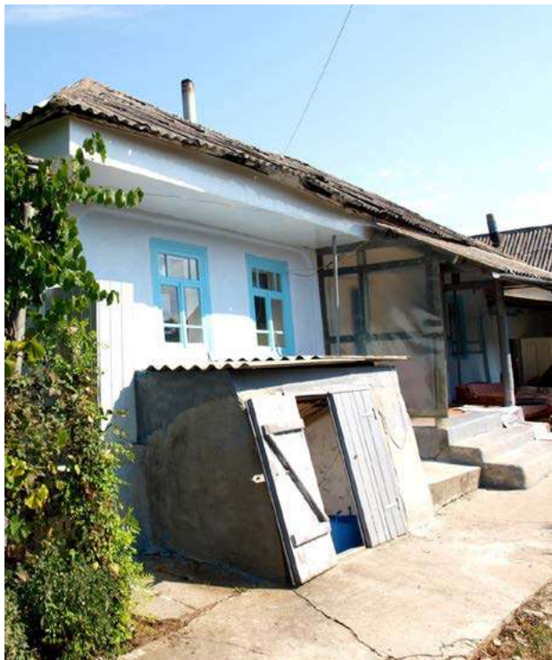
Фото 9. Большой каменно-сводчатый погреб, устроенный под домом с. Кунича. Вход в погреб – башка. Фото автора
