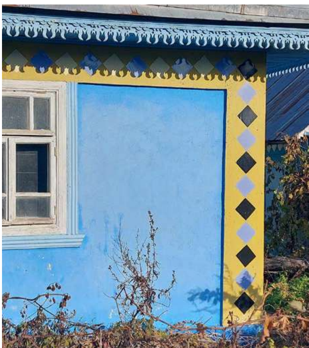
Фото 15. Украшение дома. Резной орнамент подшивки кровельных подзоров и роспись углов дома в с. Кунича. Фото автора
