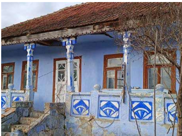
Фото 5. Традиционный молдавский дом с приспой и резными колоннами. Шолданештский р-н. Фото Ю. Швец
