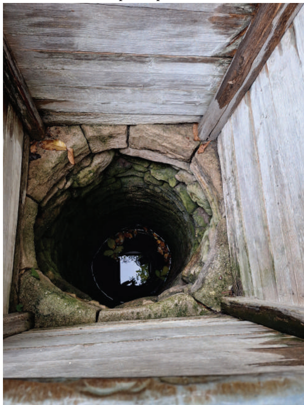
Foto 6. Imagine interioară a fântânii lui Grigore Iachim: colacul din lemn și gura fântânii cu zidurile clădite din piatră but, 4 octombrie 2025. Foto: Valentin Arapu
