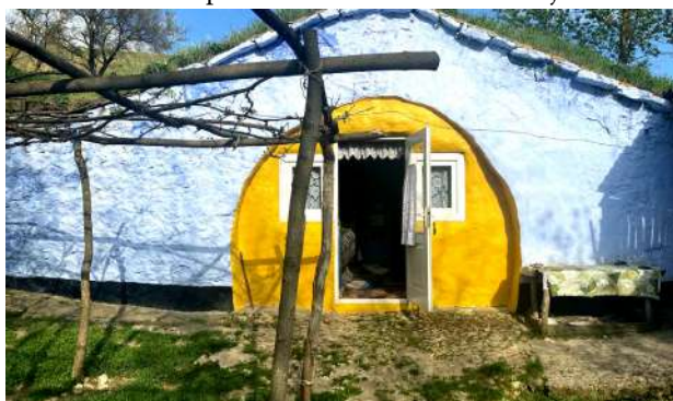
Foto 5. Bordeiu lui Maria Ardeleanu, construit de părinții soțului ei, cu aproximativ 100 de ani în urmă (satul Rogojeni, r-nul Șoldănești).
