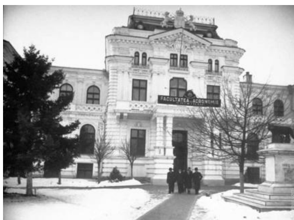
Fig. 3. Fostul liceu nr. 3 pentru băieţi [ http://oldchisinau.com/kishinyov-starye-fotografii/zdaniya-i-ulicy/?pid=250 ]
