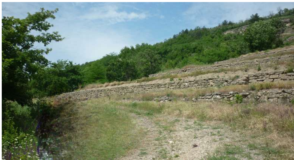
Fig. 9. Terasile consolidate cu ziduri de sprijin din piatră, înc. sec. XIX. Foto A. Trifan, 2012.
