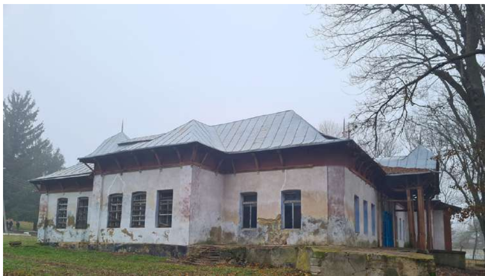
Fig.4. Fațada de est a conacului. Foto: Aurelia Carpov, 03.11.2024.
