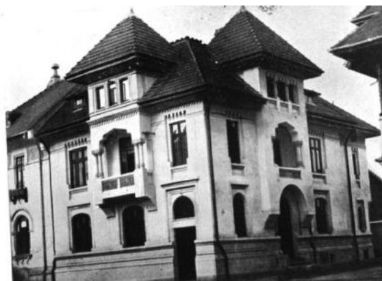
Fig. 4. Casa dr. Vișoianu – arhitect Ion D. Enescu.
