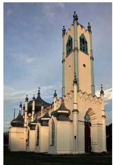
Преображенская церковь в Мошнах (Черкасская область), 1840 г. Архитектор Г. Торичелли
